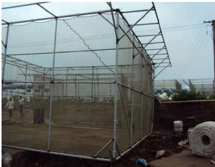
Hình 13: Kết cấu khung lồng bằng ống kẽm
