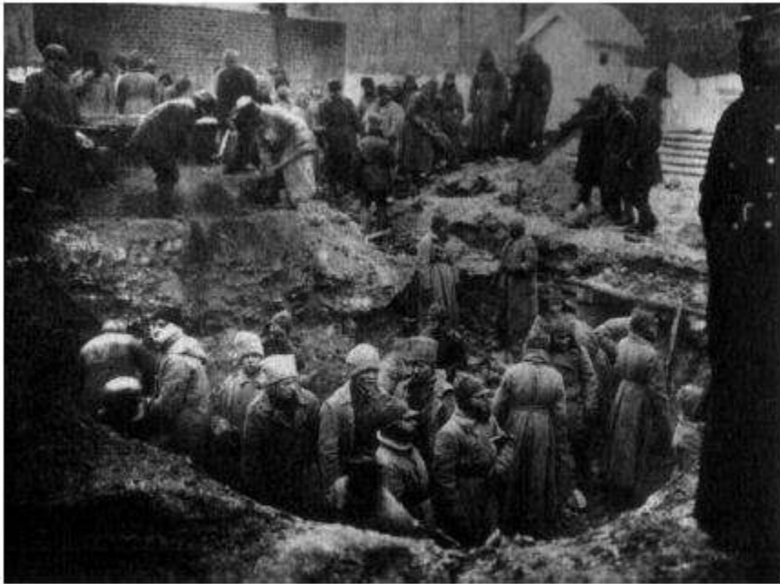
Bằng thuốc nổ, cuốc chim và xẻng, công nhân và các chiến sĩ Hồng quân đào hố móng dưới Lăng Lenin tạm thời trên Quảng trường Đỏ.
